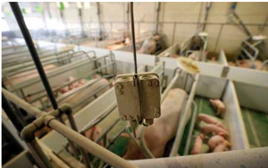
De voeler in de afdeling wordt gebruikt voor regeling van het klimaat, maar ook voor een melding bij brand. Twee aparte voelers is beter.
